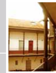
Reforma de edificio entre medianeras para viviendas local comercial, garajes y trasteros en la calle Campamento nº 29-33, Sevilla Promotor: Casa Márquez
