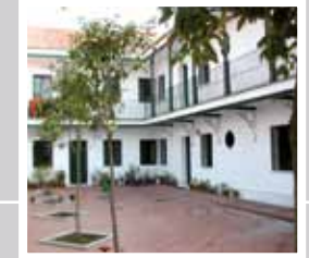
Reforma de edificio entre medianeras para viviendas, antiguo corral de vecinos Corral del Cura, c/ Pagés del Corro nº 11-13, Sevilla Promotor: Gerencia Municipal de Urbanismo de Sevilla
